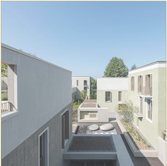
Referenz Fassadengestaltung "Jonagold", Raumfindung Architektur Rapperswil
