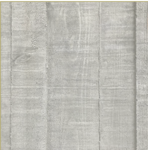
Lasur z.B. NCS S 2502 - Y Oberfläche Schalung sägerauh
