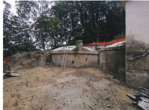
Schieberhaus rechts mit den beiden runden Reservoirbehältern
