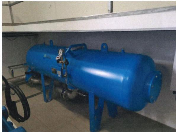
Druckschlagdämpfer zum Ausgleich von Druckschlägen, welche unter Umständen auf das Leitungsnetz beim Ein- und Ausschalten der Pumpe entstehen können
