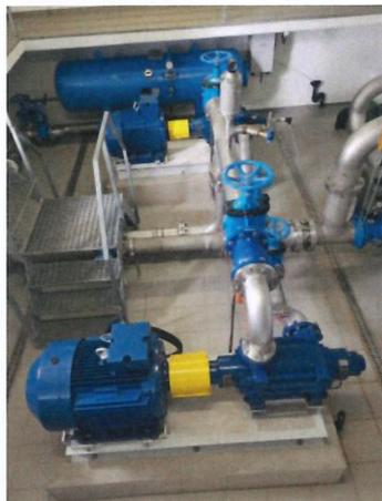
Zwei neue Pumpen mit Druckschlagdämpfer
